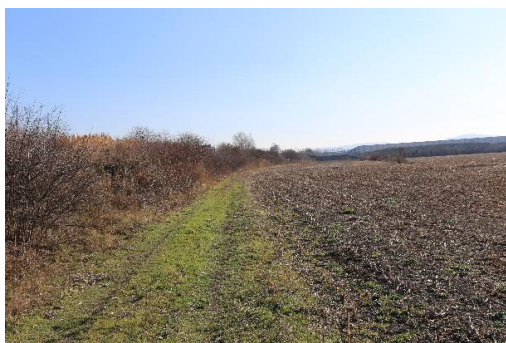
Talus de la voie ferrée (08/02/23)
