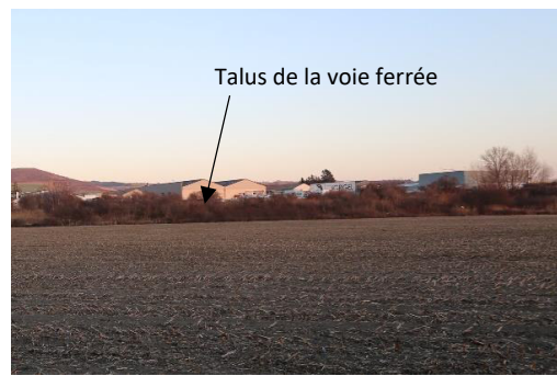
Talus de la voie ferrée (08/02/23)
